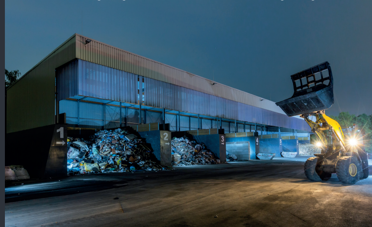
AVEA Bockenberg Bergisch Gladbach – Abfallbehandlungsanlage
